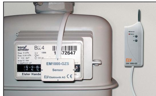
**Bild 3: So erfolgt die Fixierung des Sensors auf der Gaszähleruhr. Hier sieht man auch die Führung der Verbindungsleitung zum Sender und dessen Montage in der Nähe der Gaszähleruhr.**
