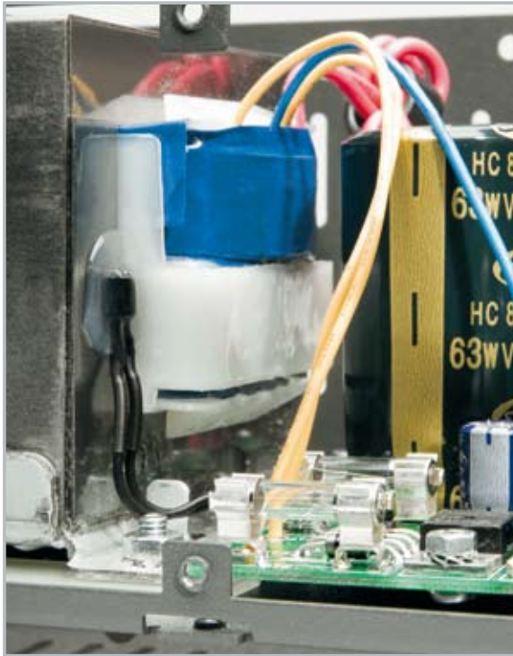
Bild 17: Befestigung des Temperatursensors am Trafo
