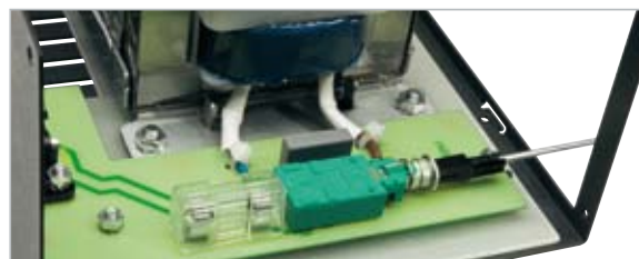
Bild 13: Anschluss der primärseitigen Trafoleitungen
