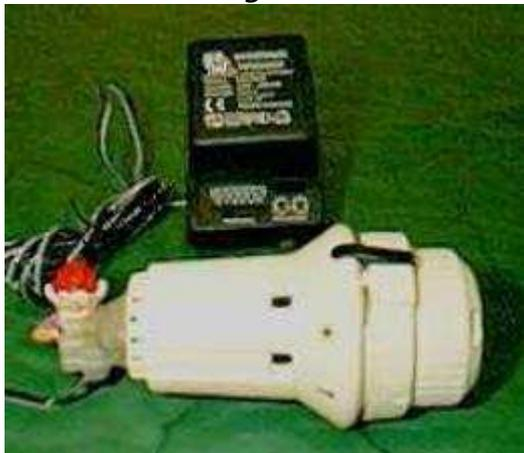
*An der Stirnseite des Kopfes wurde einfach etwas Plastik entfernt und ein Widerstand und Anschlussklemmen mit Heißkleber aufgeklebt. (Der Zwerg hält das Ventil für das Foto gerade.)*
