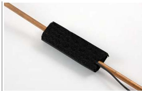
5) Recouvrir le capteur d'isolant thermique sur au moins 10 cm aux extrémités du bouchon et du câble enroulé ;
