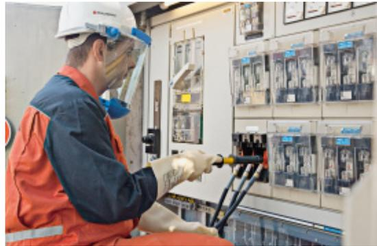
AuS-Tätigkeit: Montage des NH-Steckzeinsatzes zum Anschluss eines Notstromaggregats
