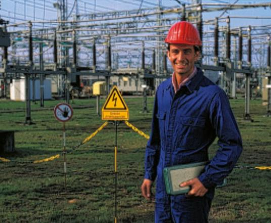
Gute Kennzeichnung der Arbeitsgrenzen in einer 110-kV-Freiluft-Schaltanlage
