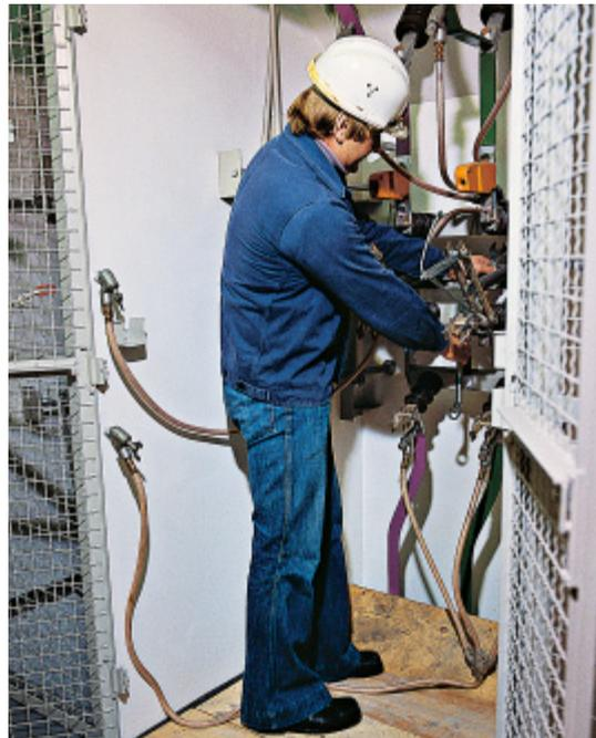
Einlegen der Erdungs- und Kurzschließvorrichtung in einer Mittelspannungsschaltzelle
