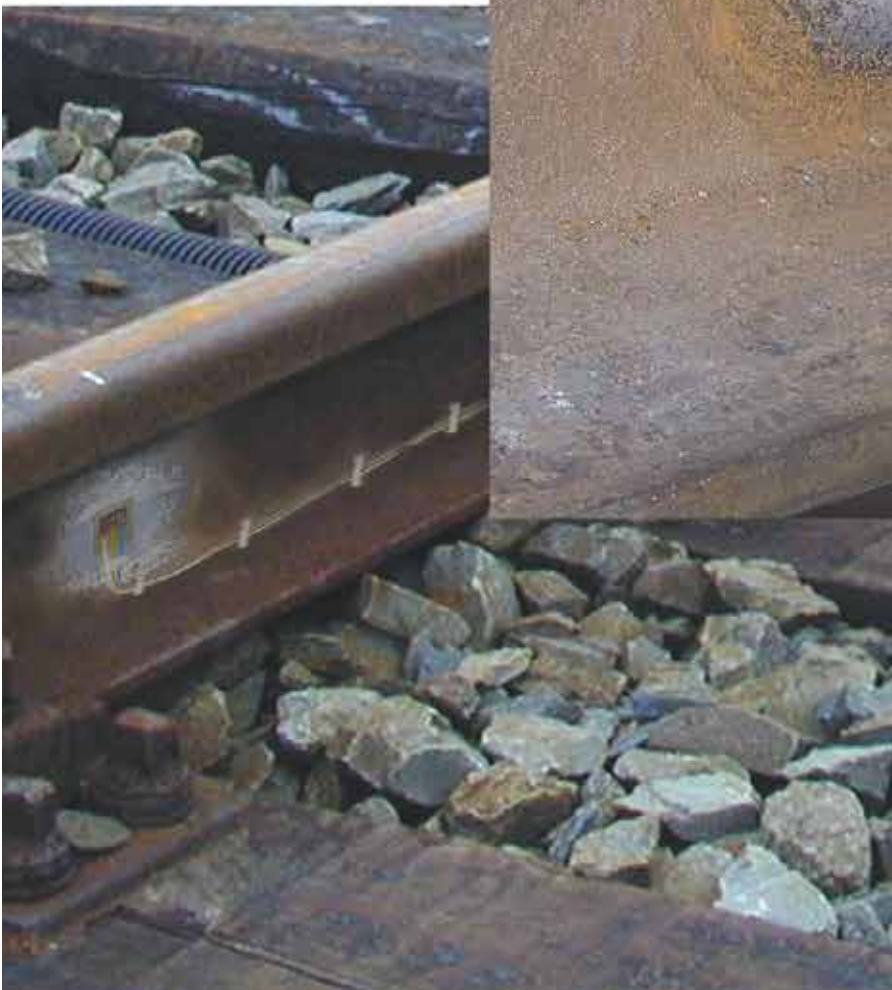
Experimentelle Untersuchungen an einer Eisenbahnschiene
