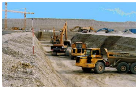
Einfache Vermessung bei Tiefbauarbeiten
