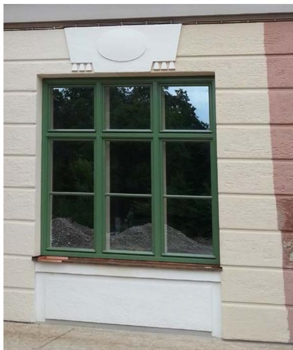
**Bild 1** Fachgerechte Sanierung einer "Denkmalsünde" durch Nachbau der alten Holzfenster
