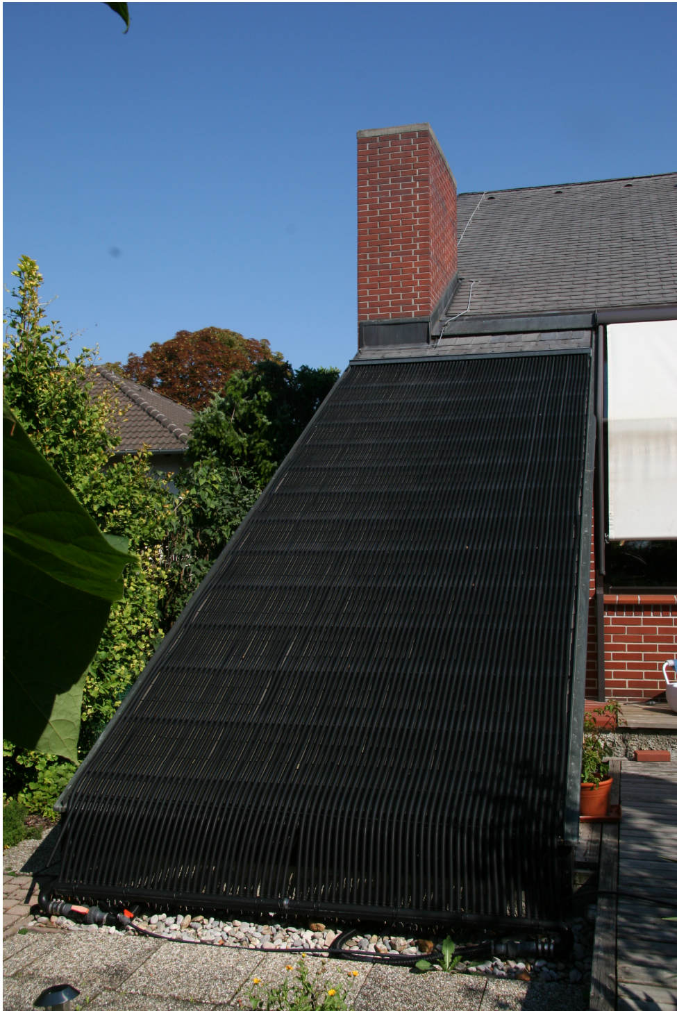
Ausführung auf Eternit Doppeldeckung, südseitig, 30 Grad ca 8x2.5 m Installiert 2002
