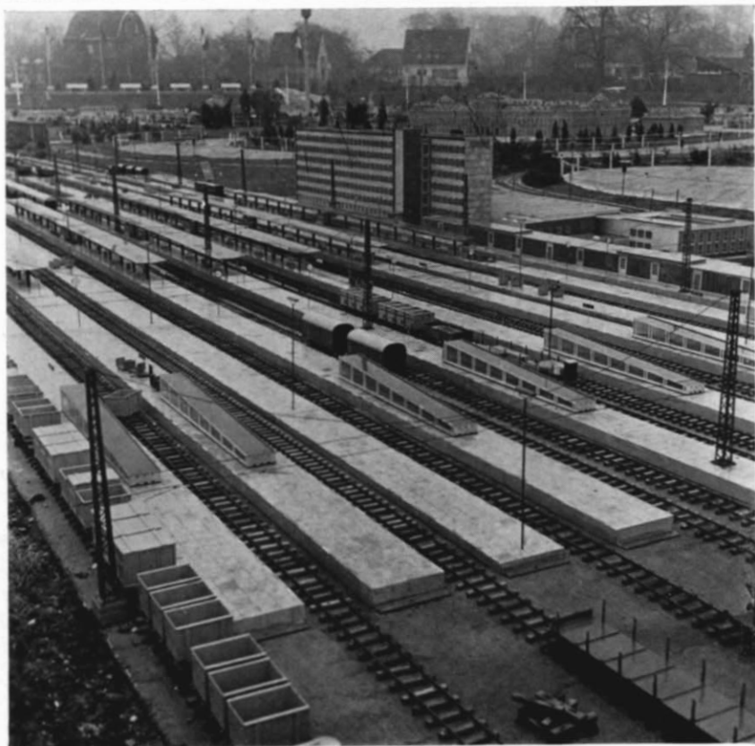
Abb. 3. Blick auf das Bahnhofsgelände mit teilweise überdachten Bahnsteigen und dazwischen liegenden Ladesteigen. Auf die Andeutung der überdachten Bahnsteig-Niedergänge wurde ebenfalls nicht verzichtet. Im übrigen beachte man auch den Größenvergleich mit den „richtigen“ Menschen im Hintergrund (s. a. Abb. 1).
