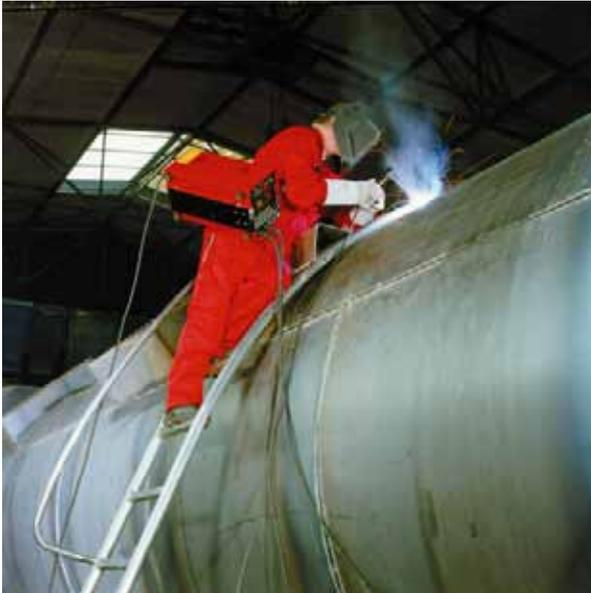
**Bild 21** Anwendung des E-Hand-Schweißens im Behälterbau
