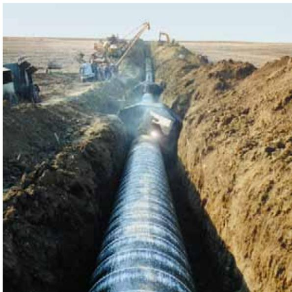
**Bild 6** Schweißen im Rohrleitungsbau mit Zellelektroden
