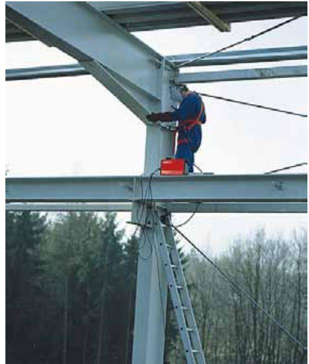
**Bild 20 Einsatz der Inverter-Schweißstromquelle PICO 162 auf der Baustelle**
