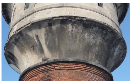
Ryc. 4. Gzyms wieńczący trzon głowicy wieży ciśnień przy dworcu kolejowym w Żninie. Źródło: il. autora
