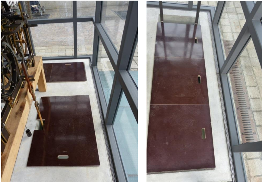
Bild:2.5.2: Öffnungen mit Bodenplatten (selbst erstelltes Foto)
