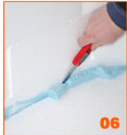
Nach einer Trockenzeit von ca. 25 Minuten muss der überstehende Schaum entfernt werden und der Boden von Verunreinigungen gesäubert werden – im Optimalfall mit einem Staubsauger.
