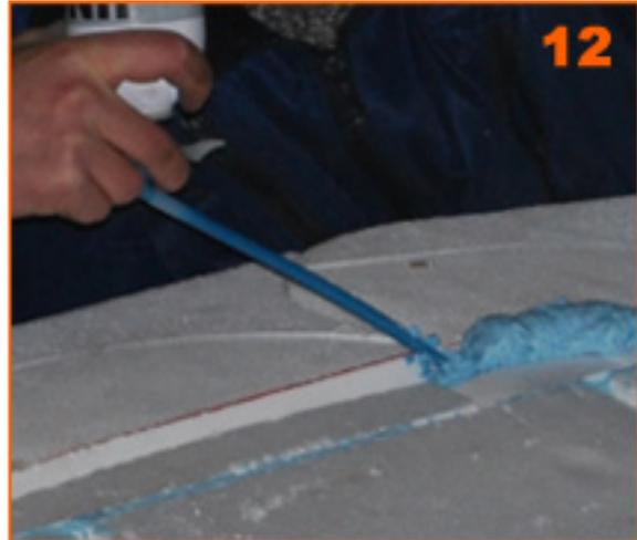
Beide Deckelhälften auf der Schichtungssäule aufliegen lassen und den Rest bündig mit den Dämmsteinen abschließen lassen. Die Zwischenräume sind genau so wie beim Speicherboden auszuschäumen!
