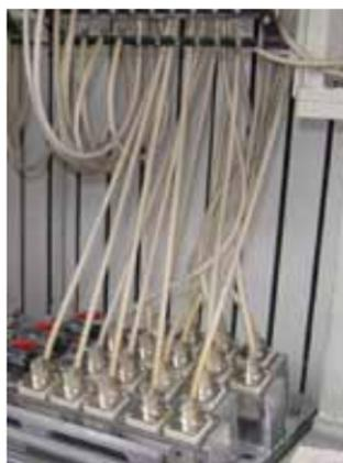
*Bild 3.8.2 – Sandbefüllung der NH-Sicherungseinsätze*
