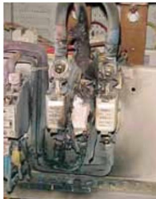
Bild 5.8.1 – Missglückte Abschaltung einer Stromresonanz
