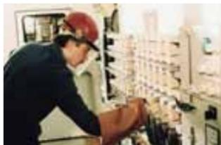
Bild 3.2.4 – Betätigung von NH-Sicherungseinsätzen unter Last
