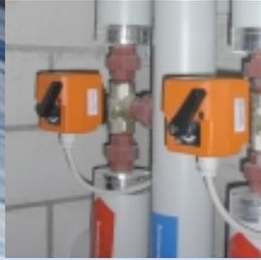
Motorisierte Regel-Kugelhähnen für HLK-Wasserkreisläufe
